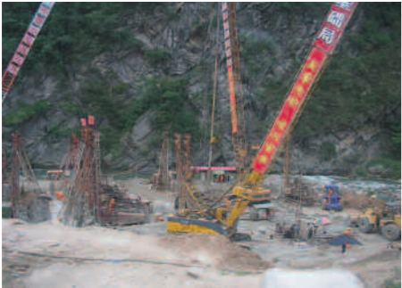
四川の山岳地域は、観光開発のための道路工事がさかんに行われている。豊かな資金と天然の資源とでインフラを整備中である。
