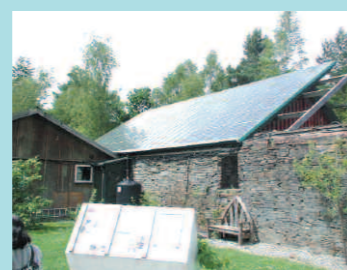
レストランの屋根にも太陽光発電パネルを設置。
