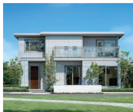
一般的なソーラー住宅の2倍以上の大容量ソーラーを搭載。快適な空気環境が省エネルギーで実現する新世代住宅「スマートハイム」（積水化学工業）
