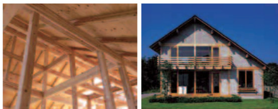
(右) 外壁真壁、急勾配の屋根と深い軒が特徴の郊外型の住まい。(左) 5寸柱を使った木組み現し構造。
