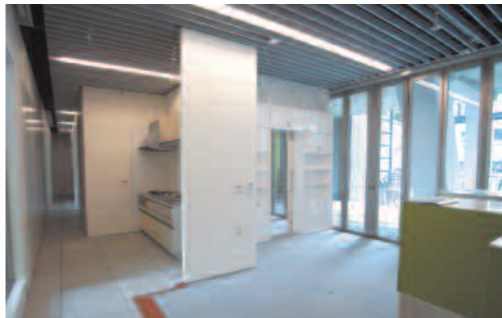
(上) 実験施工後の「Glass Cube」。可動間仕切り家具などの可変インフィルによって間取りが形成される。(右) 実験施工前の「Glass Cube」。
