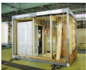
工場に搬入されたユニット。20年前に建設されたユニットの鉄骨は耐久性を保ったまま。
