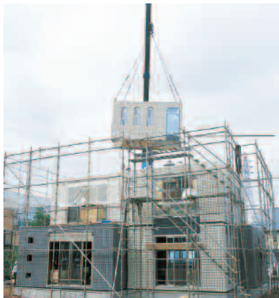
ユニットの再利用に加え、ユニット単位の解体・建設は現場での廃棄物を抑えるメリットもある。
