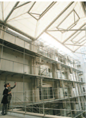
構内アトリウムに架けられた新工法によるテント屋根（設計／藤井明）。
