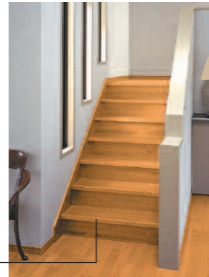
踏み板の手前部分に滑り止めの溝が入っている。
